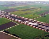
Bau des «WB»-Tunnels in der Grenchner Witi.
