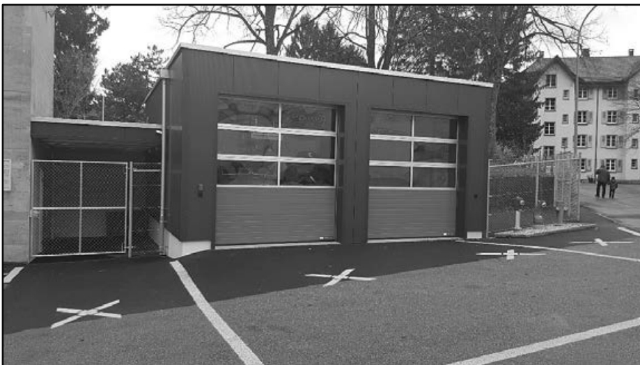
Anbau Fahrzeughalle für zwei Fahrzeuge und Material
